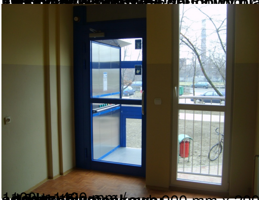
Platformy pionowe z napędem śrubowym (900 mm x 2000 mm (pełne przeszklecie lub panoramiczna szyba).
